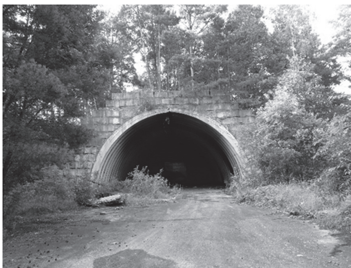
Ryc. 4. Opuszczony hangar na lotnisku w Wiechlicach-Osiedlu
