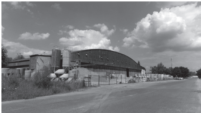
Ryc. 3. Hangar lotniczy przekształcony na magazyn wyrobów betonowych miejscowego przedsiębiorstwa przy lotnisku w Chojnie
