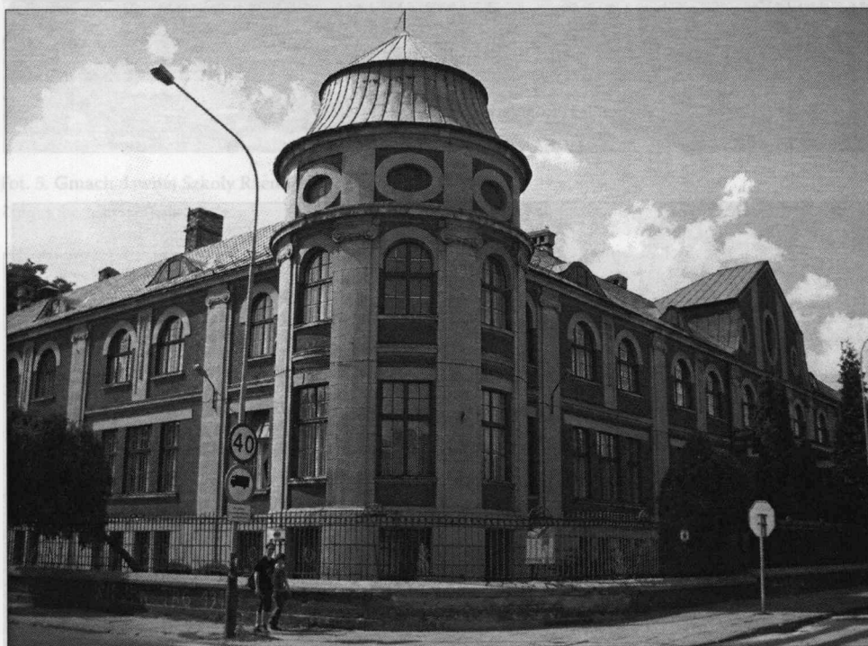
Fot. 9. Budynek Wyższej Szkoły Sztuki i Projektowania
