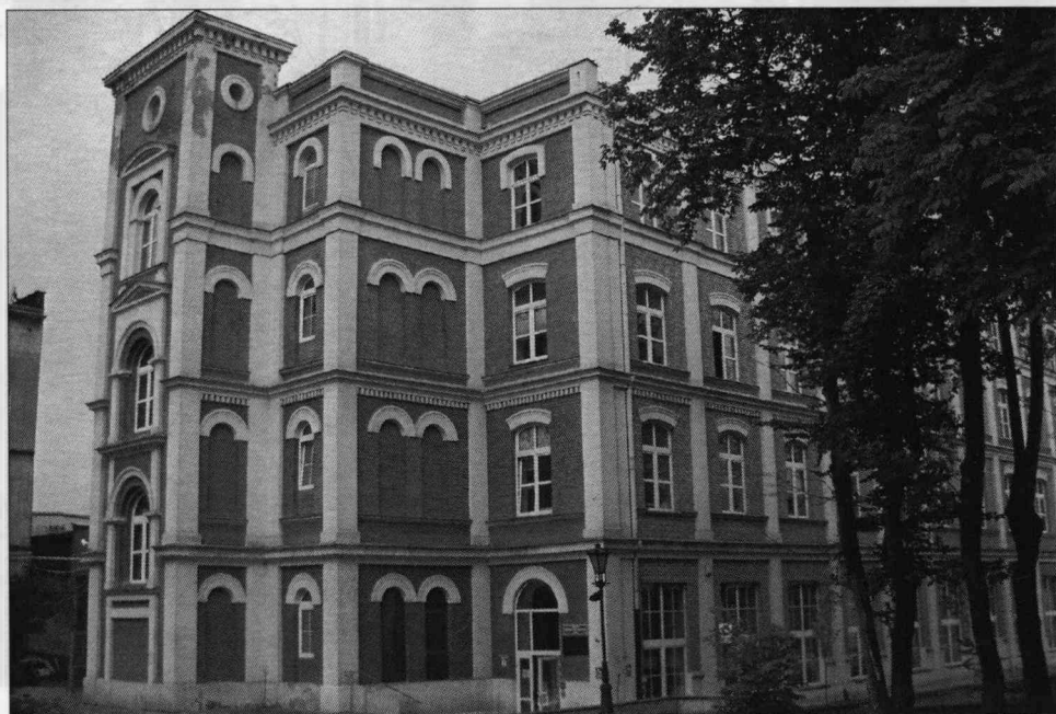
Fot. 6. Zrewitalizowana fabryka F. Goldnera
