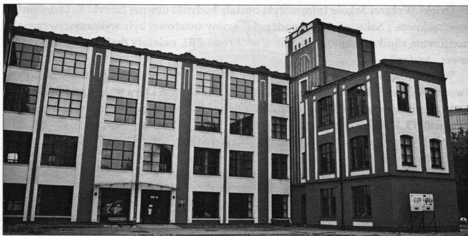
Fot. 7. Budynek Biblioteki Akademii Humanistyczno-Ekonomicznej
