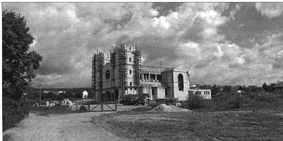
Fot. 1. Budowa nowego kościoła w Krzeszowicach
