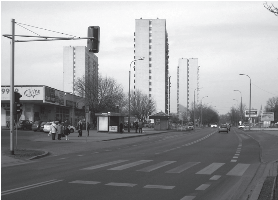
Fot. 2. Poznań, ul. Murawa, w ciągu której proponuje się przeprowadzenie torowiska
