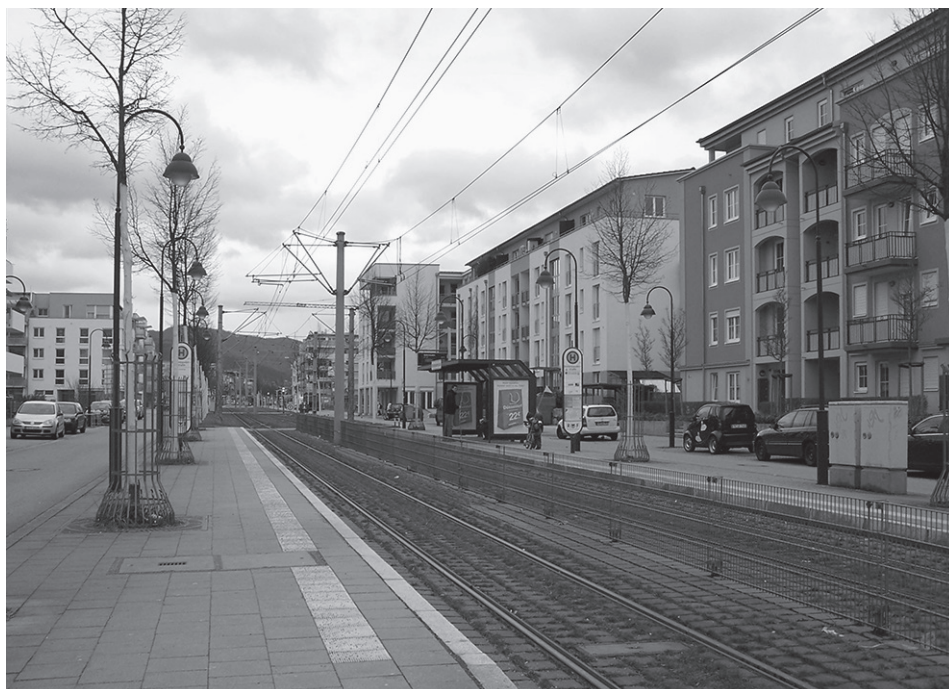
Fot. 1. Freiburg (Breisgau), Niemcy – trasa tramwajowa prowadzona centralną częścią osiedla
