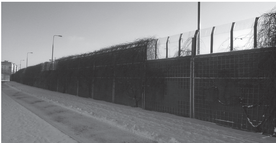
Fot. 3. Roślinność pnąca na ekranach akustycznych na Terenie I (fot. K. Podawca)
