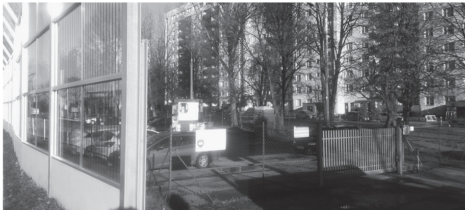
Fot. 7. Parking pomiędzy ekranem akustycznym a zabudową mieszkaniową na Terenie II (fot. K. Podawca)
