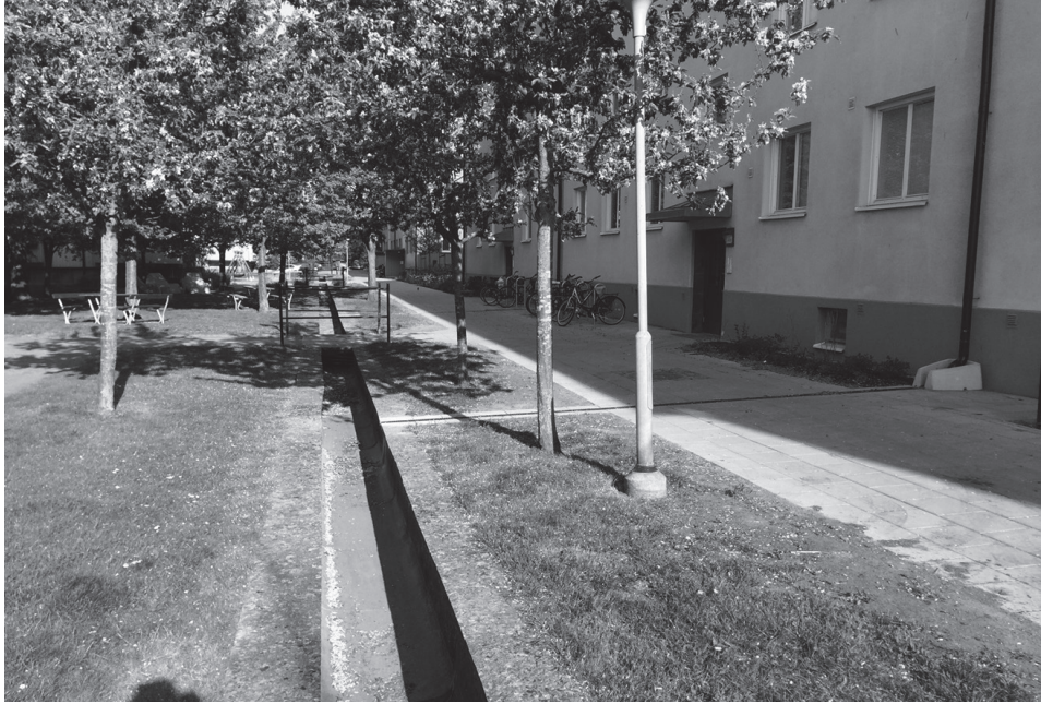
Ryc. 3. Ekostaden Augustenborg, Malmö, otwarty system kanalizacji deszczowej (fot. K. Puzdrakiewicz)
