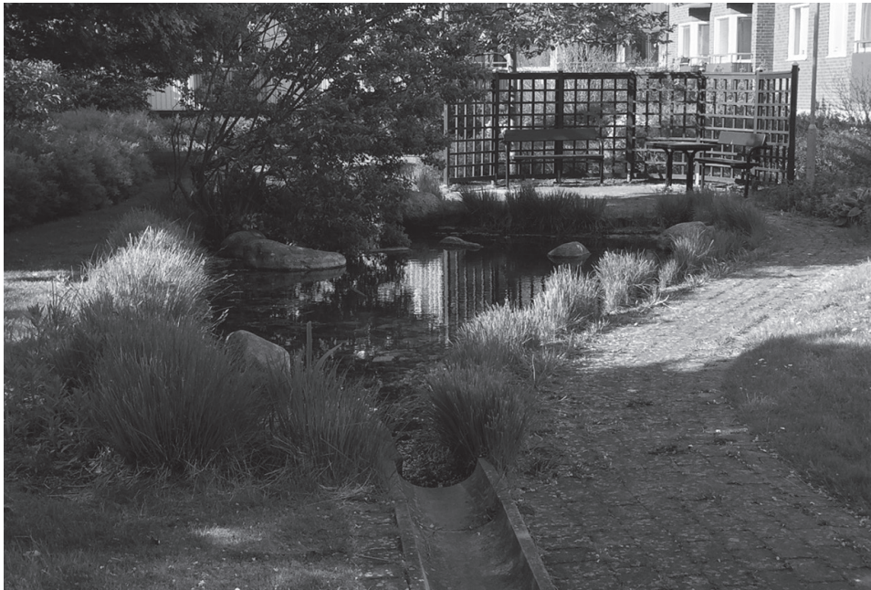
Ryc. 4. Ekostaden Augustenborg, Malmö, otwarty system kanalizacji deszczowej (fot. K. Puzdrakiewicz)
