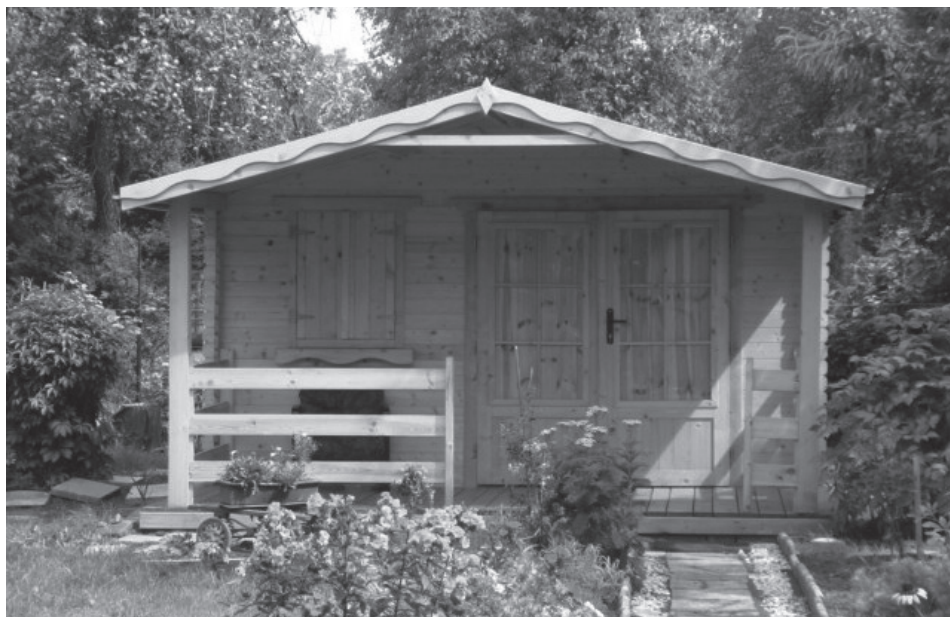
Rys. 6. Przykład nowej altanki w ROD im. J. Chociszewskiego w Poznaniu, która zastąpiła zabytkową Fot. D. Dymek.
