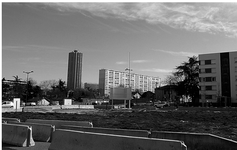
Ryc. 2. Fragment osiedla La Duchère w Lyonie po wyburzeniach – przygotowany pod nową zabudowę
