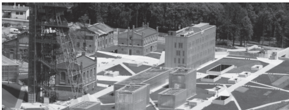
Rys. 4. Nowa siedziba Muzeum Śląskiego a) projekt nowej siedziby Muzeum Śląskiego na terenie po byłej KWK Katowice b) nowa siedziba Muzeum Śląskiego w 2013 r.
