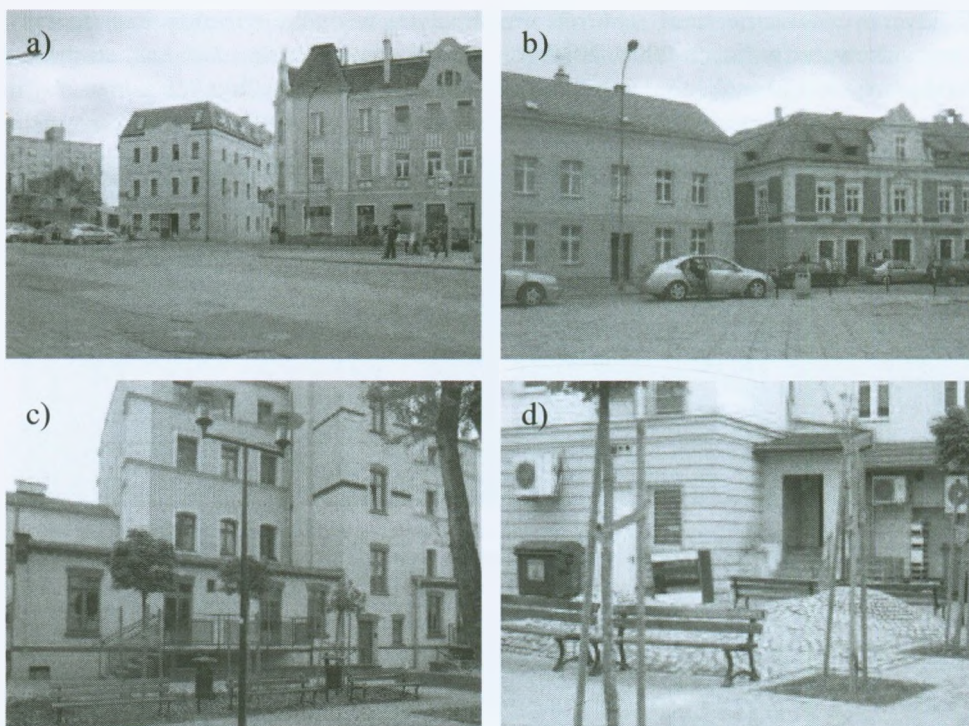
Fot. 3. Dotychczasowe efekty rewitalizacji Psiego Pola: a), b) realizacja prac przy ul. B. Krzywoustego; c), d) pasaż handlowy, a zarazem miejsce do spacerów i spędzania wolnego czasu na tyłach kamienic przy ul. B. Krzywoustego
