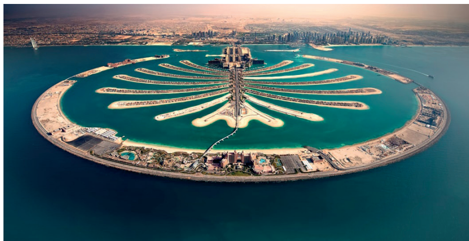
Ryc. 1. Palm Jumeirah w trakcie budowy
