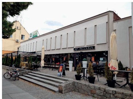
Fot. 1. Budynek byłego kina Piast w Sieradzu – widok od strony ulicy, 16.07.2022 r.
