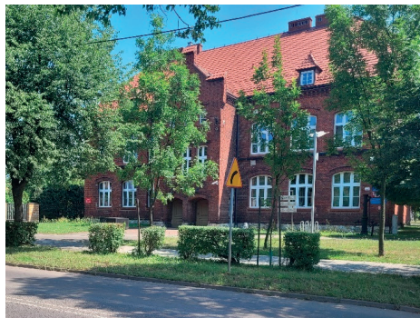
Fot. 2. Siedziba PGK sp. z o.o.
