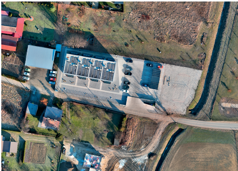
Ryc. 6. Zdjęcie z realizacji zabudowy
