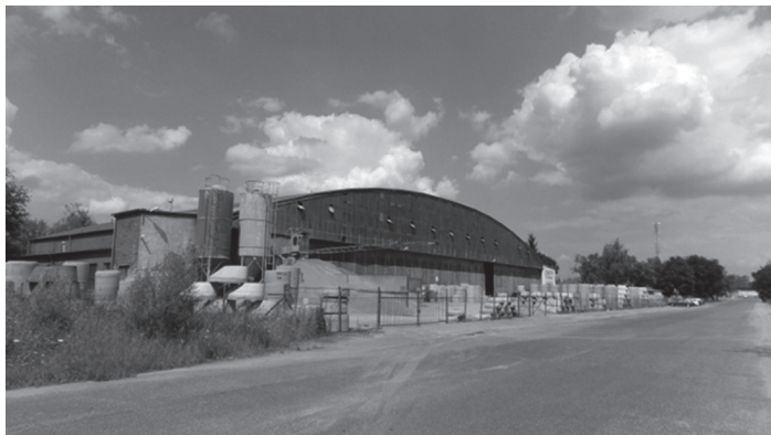
Ryc. 3. Hangar lotniczy przekształcony na magazyn wyrobów betonowych miejscowego przedsiębiorstwa przy lotnisku w Chojnie
