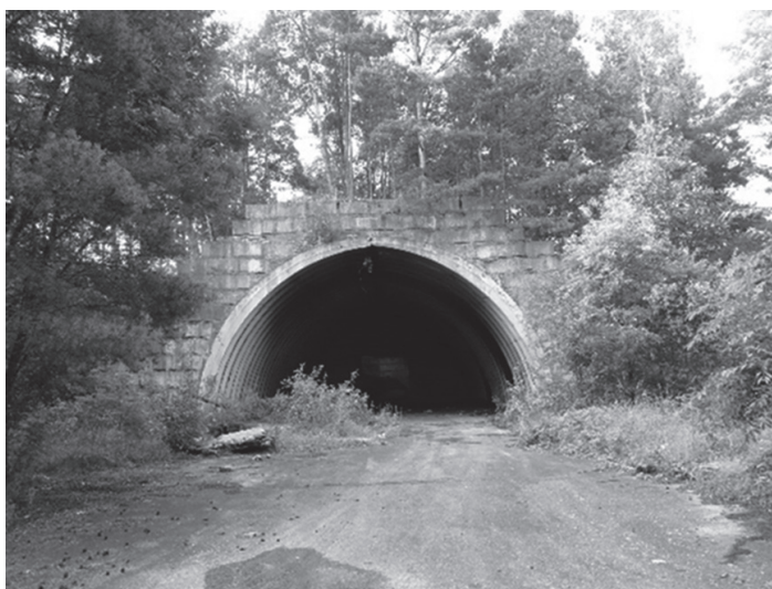
Ryc. 4. Opuszczony hangar na lotnisku w Wiechlicach-Osiedlu
