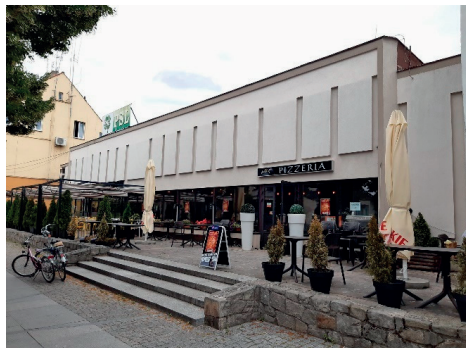
Fot. 1. Budynek byłego kina Piast w Sieradzu – widok od strony ulicy, 16.07.2022 r.
