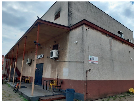
Fot. 2. Budynek byłego kina Piast w Sieradzu – widok od strony zapleczka, 16.07.2022 r.
