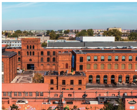
Fot. 6. Fragment kompleksu po ukończeniu prac remontowych
