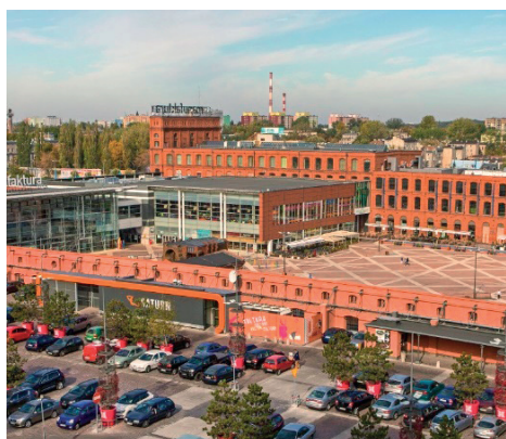
Fot. 8. Dawny budynek przędzalni z widokiem na pasaż handlowy po pracach remontowych
