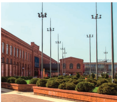
Fot. 9. Dawny budynek tkalni po ukończeniu prac remontowych
